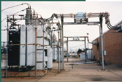
Электростанция, CLiP 5,5 кВ 3000 А
