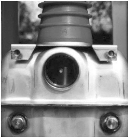
Смотровое окошко в баке выключателя нагрузки
