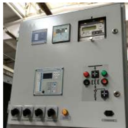
Рис. 4.4 Релейный отсек
