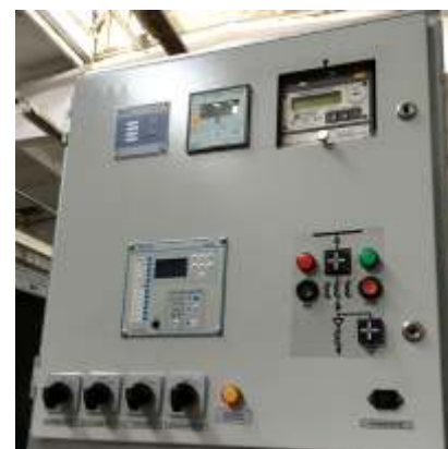
Рис. 4.4 Релейный отсек
