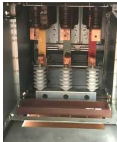
Рис. 4.3 Отсек присоединений
