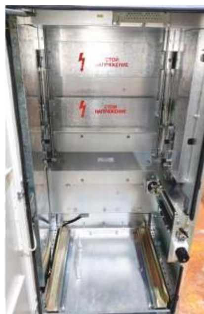
Рис. 4.2. Отсек выкатного элемента
