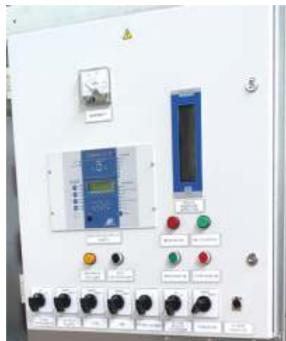
Рис. 4.4 Релейный отсек
