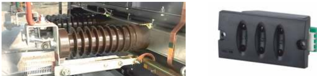
Рис. 5.7. Емкостный делитель напряжения (слева) и указатели (справа)
