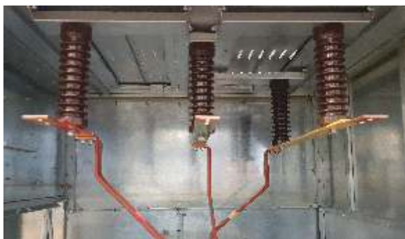
Рис. 3.2. Расположение сборных шин
